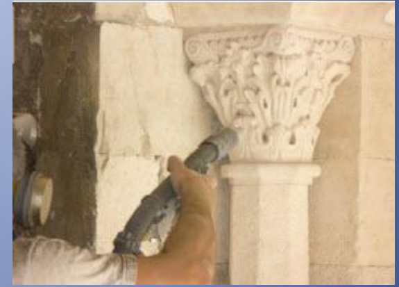
Nettoyage de parements en pierre de taille par procédé de gommage
