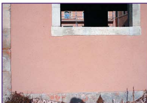
Support traité avec SANIMUR®
