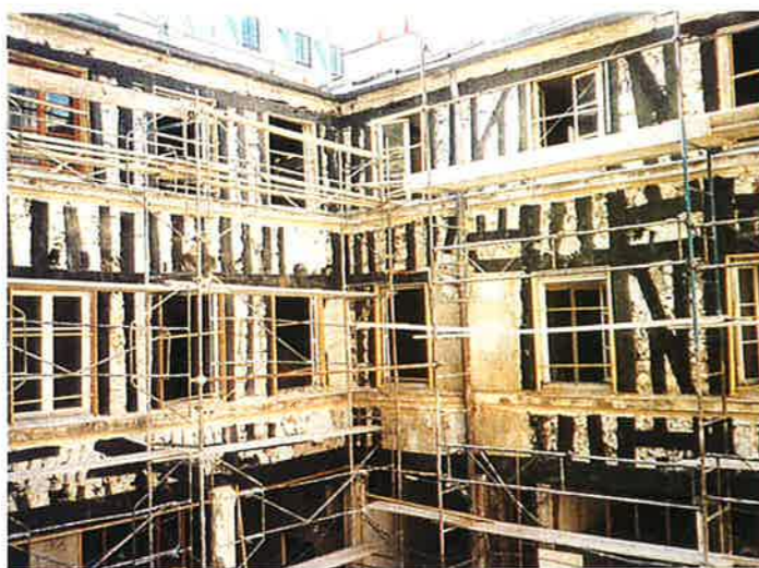
Dans l'historique quartier du Marais parisien, la préparation des supports d'un ensemble de bâtiments en cours de réhabilitation. Les piquages achevés, une première couche d'un mortier de chaux + sable, le «dégrossi», sera appliquée sur ces façades tricentenaires.
